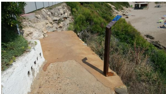
Replà existent en el punt M-100 que guiarà el camí cap a el nou traçat M-100/M-102 millorat.
